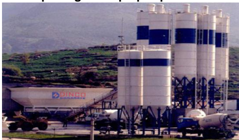
Hệ thống thiết bị hiện đại
