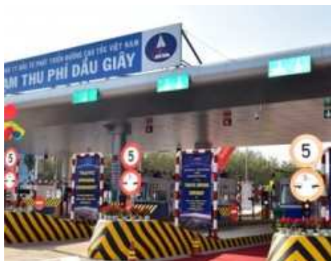
Hệ thống thu phí đường bộ
