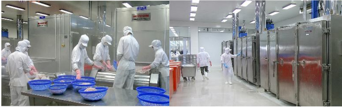
Hình 12: Hệ thống cấp đông hiện đại trong Nhà máy thủy sản số 1
