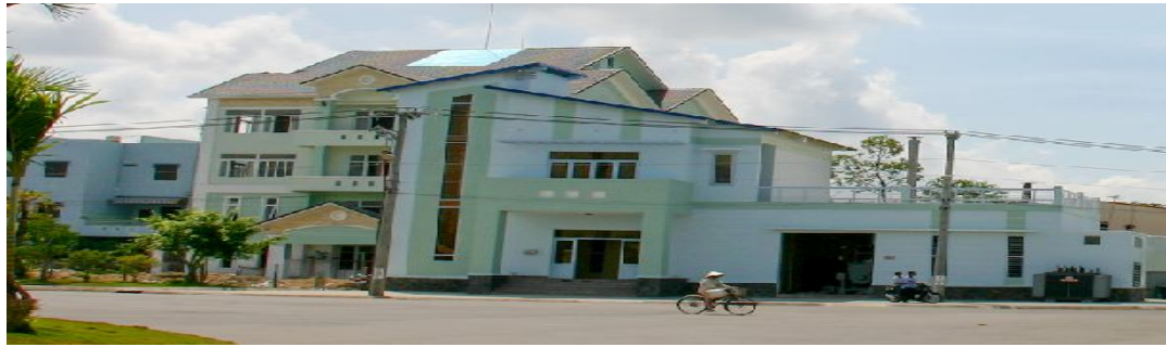
Hình 14: Trạm phát điện của Nhà máy thủy sản
